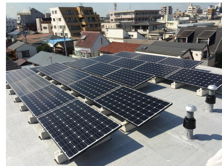
【商業ビル屋上への太陽光発電施工例】
