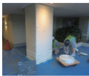
高延性材でコンクリートの柱を被覆するSRF工法（包帯補強）。柱が5cmほど太くなるだけで、建物はそのま利用可能
